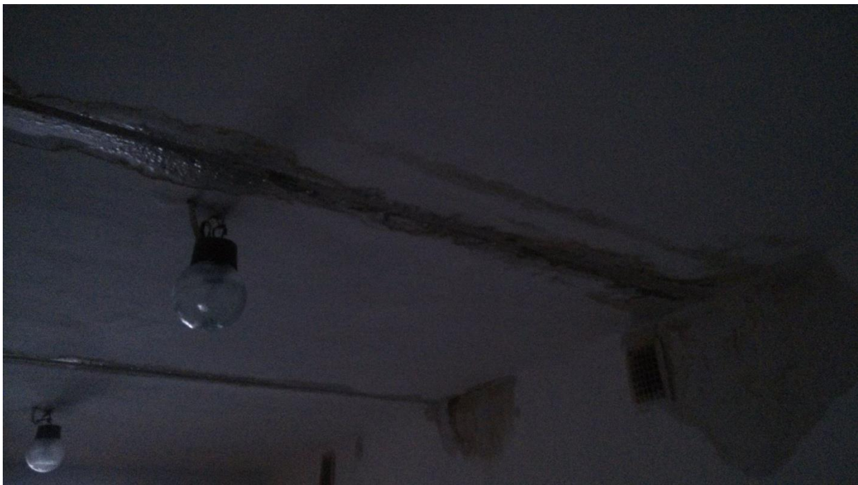
Спальный корпус, комната гигиены 3 этаж
