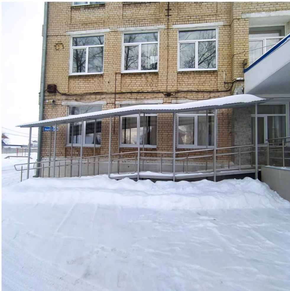
1. Пандус центрального входа
